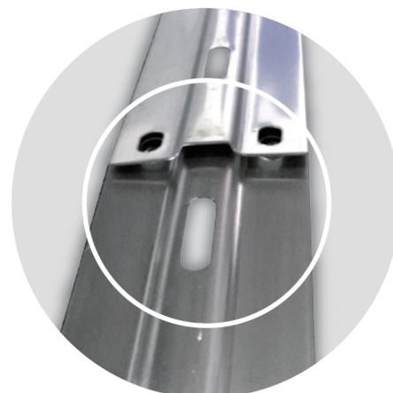
Observe el acople que deben tener los *soportes acanalados* antes de fijarse sobre las *vigas superiores* (Hay uno de mayor ancho que debe superponer el otro.)
