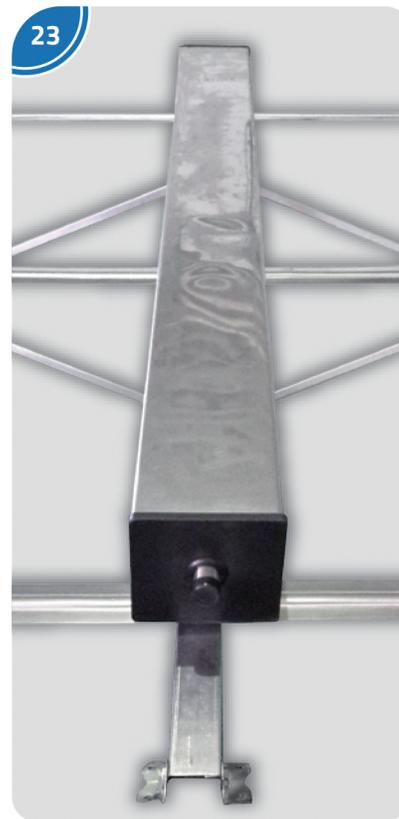
Esta es la visual desde arriba del *cabezal central* instalado sobre la estructura del colector.
