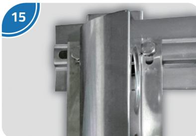
Seguidamente, ubique los *recibidores de los tubos (2)* a cada lado de la estructura, e instálelos según corresponda sobre las *vigas superiores laterales*, con 2 juegos de tornillo y tuerca cada uno.
